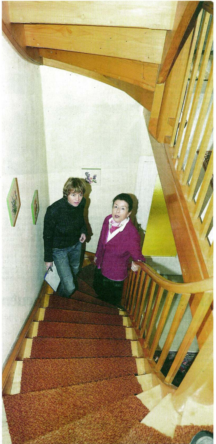
Zu steil: Die Treppe ist ein Gefahrenpunkt, hier muss ein Lift eingebaut werden.
