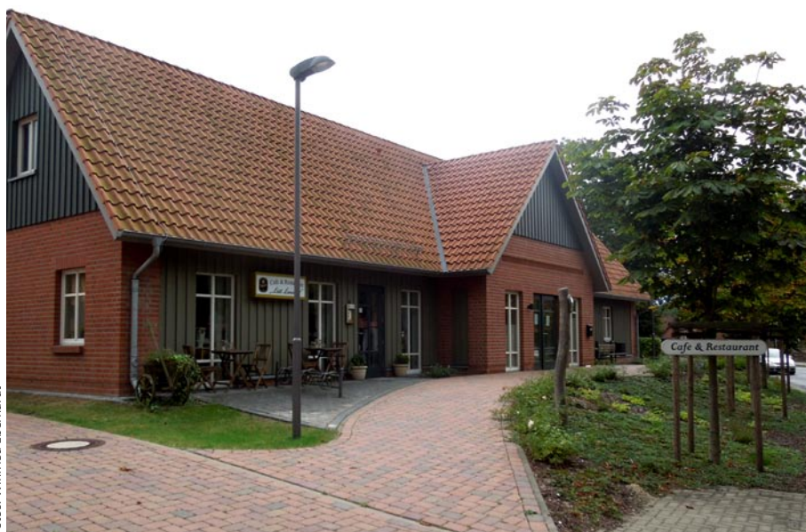
Das SÖZ in der Ansicht von der Dorfstraße aus mit Bistro
